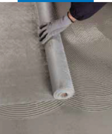
Раскатка Mapenet Sel поверх первого мокрого слоя Mapelastic Turbo
