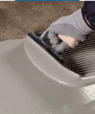
Нанесение первого слоя Mapelastic Turbo
