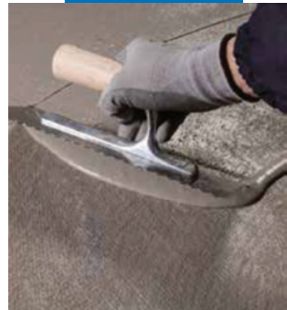
Нанесение второго слоя Mapelastic Turbo поверх первого, армированного Mapetex Sel
