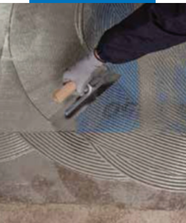
Укладка Mapenet 150 в первый мокрый слой Mapelastic Turbo
