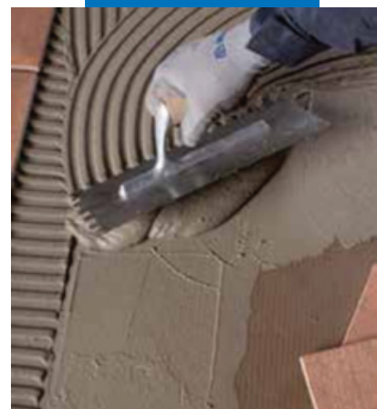
Приклеивание плитки на Elastorapid
