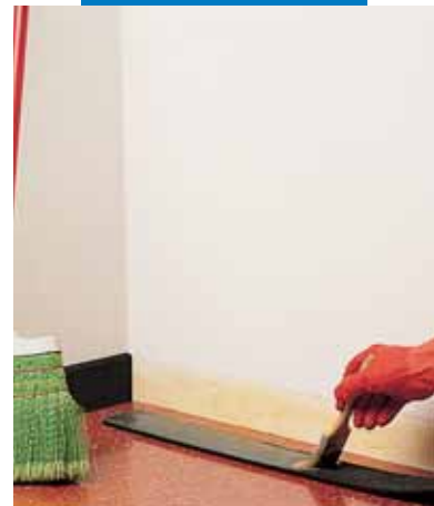
Нанесение Adesilex VZ на тыльную сторону плинтуса
