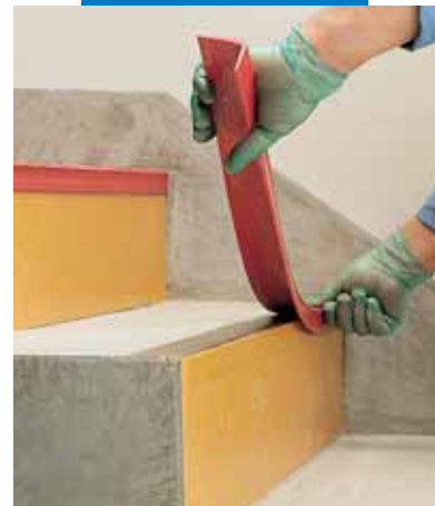
Приклеивание внешнего уголка из ПВХ для ступени
