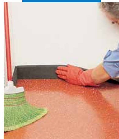
Приклеивание плинтуса из ПВХ
