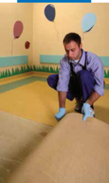
Укладка линолеума с основой из натурального джута
