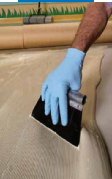
Нанесение Ultrabond Eco 520
