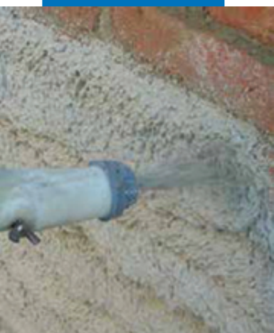
Нанесение MapeWall Intonaco Base штукатурной станцией поверх стены из полнотелого кирпича
