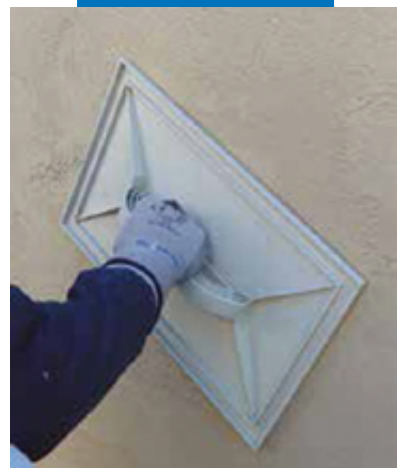
Разглаживание поверхности MapeWall Intonaco Base
