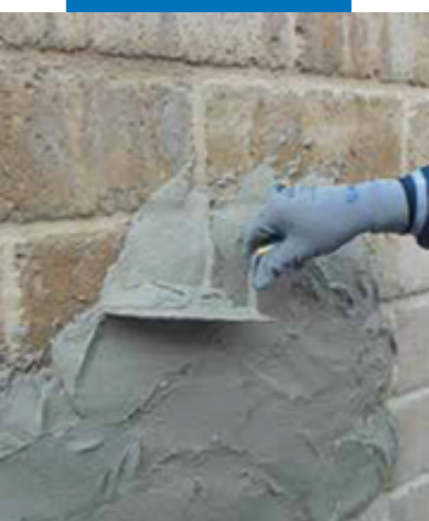
Нанесение MapeWall Intonaco Base шпателем поверх стены из туфовых блоков
