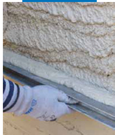
Выравнивание поверхности MapeWall Intonaco Base с помощью правила
