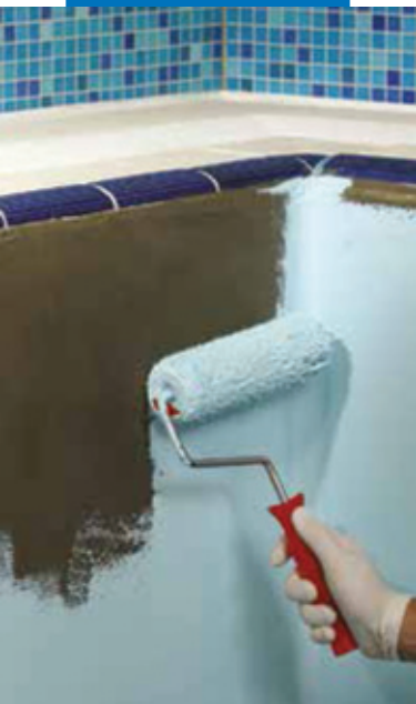
Нанесение Elastocolor Waterproof валиком
