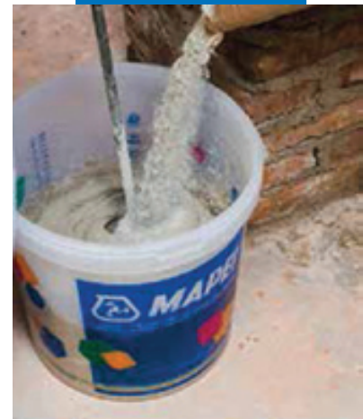
Приготовление MapeWall Muratura Fine
