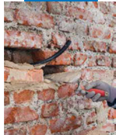
Заделка кабельного канала
