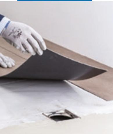
Укладка напольного покрытия LVT с помощью Ultrabond Eco MS 4 LVT во влажной среде
