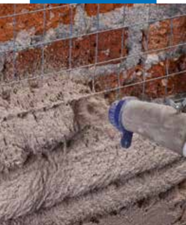
Spray-application of Mape-Antique Strutturale NHL
