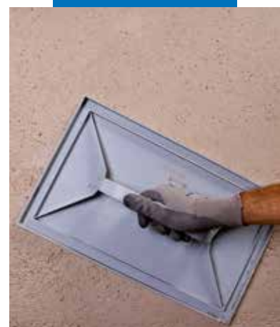
Levelling the render Mape-Antique Strutturale NHL
